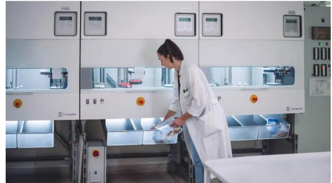
Jedan od najvećih bolničkih transportnih sustava na svijetu sa preko 16km pneumatskih cijevi, 145 jedinica za slanje i 5 automatiziranih stanica za prihvata kapsula
